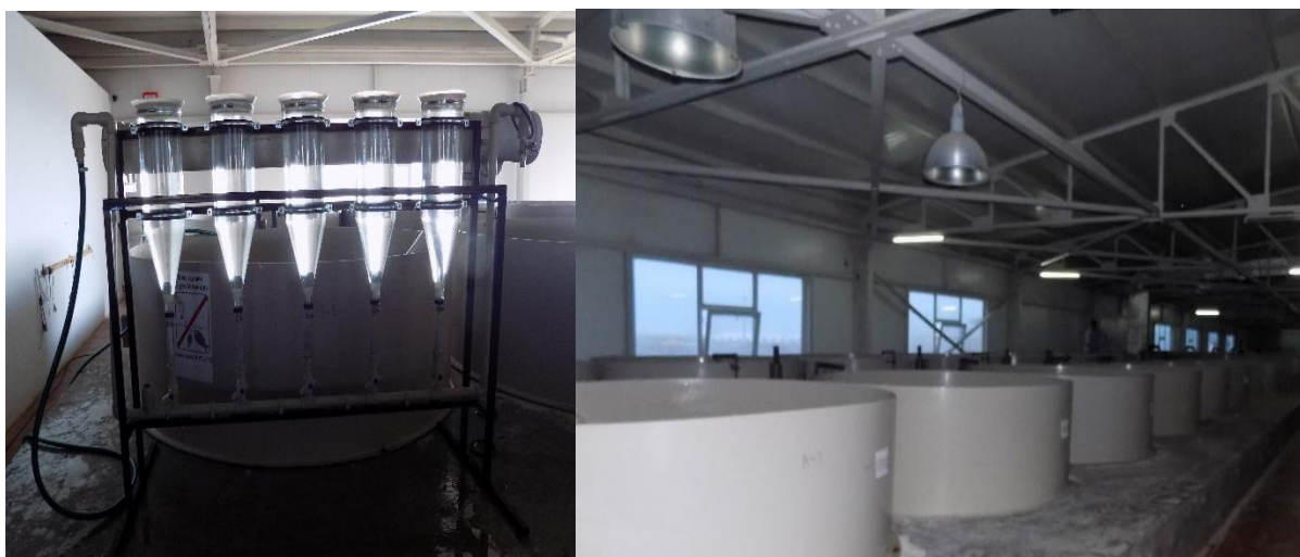
Сурет 26 - Сүйрік личинкаларын өсіру үшін Вейс аппараттары бар бағаналар мен бассейндер
